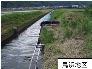
写真2 水田魚道設置後の様子
