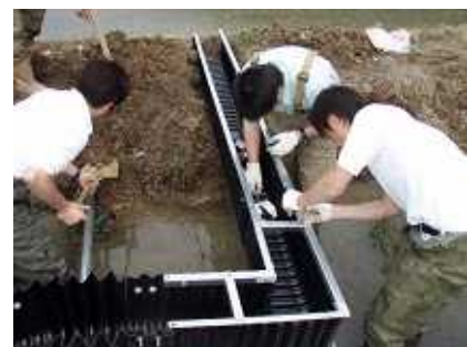
写真 1 水田魚道の設置風景
