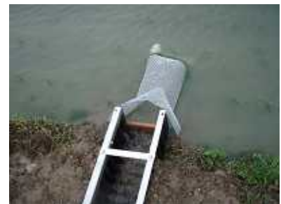
写真3 遡上トラップ設置状況
